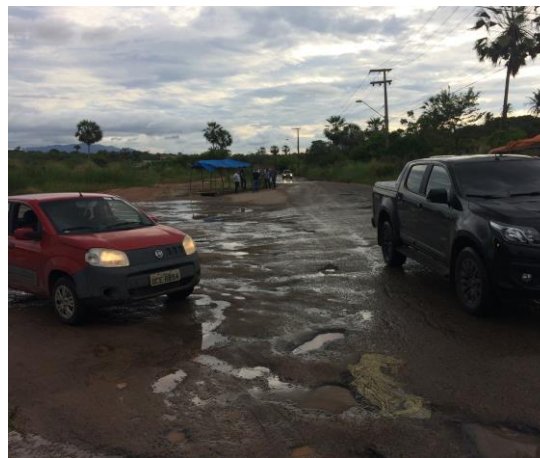
Figura 03.02 – Ausência de drenagem e deformações no pavimento da Av. Dionísio Leonel Alencar (Fonte: SEINF, Abril/19)
