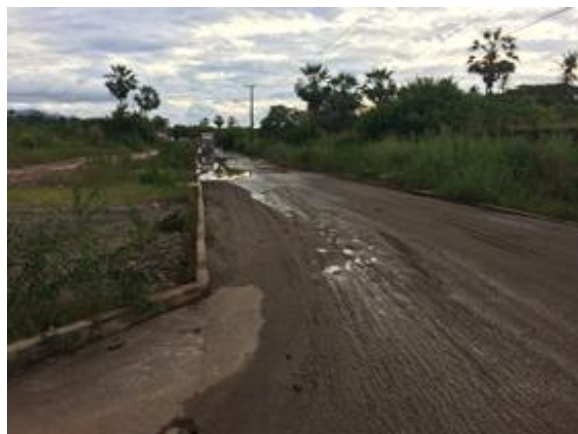
Figura 03.03- Ausência de drenagem e calçadas da Av. Dionísio Leonel Alencar (Fonte: SEINF, Abril/19)
